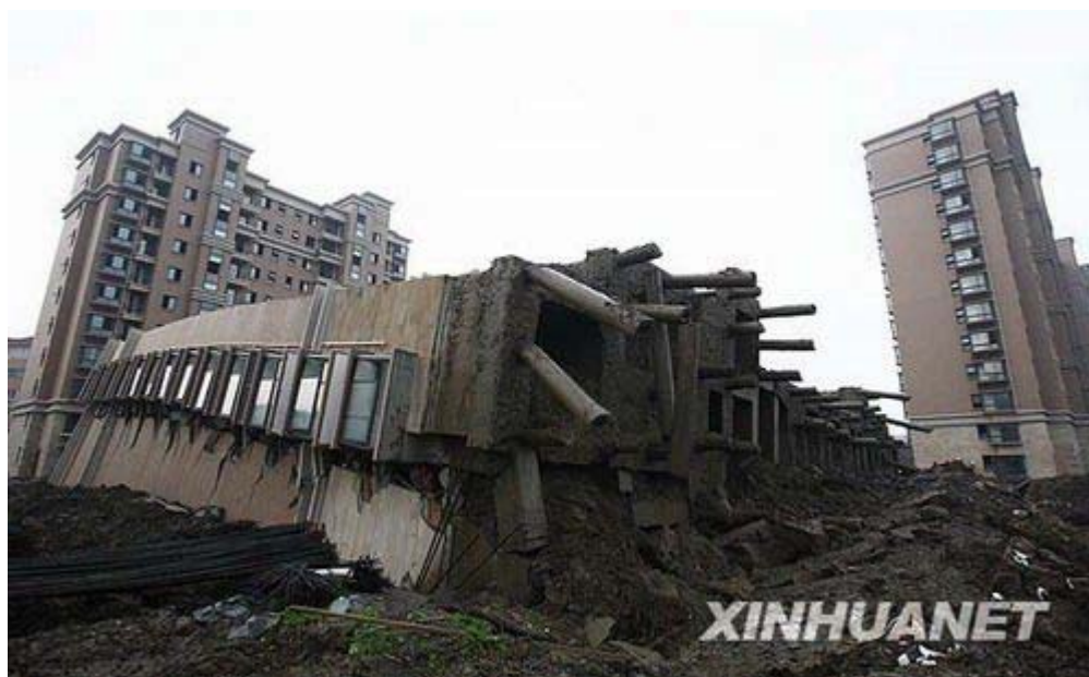
6月27日，倒塌的商品房地基全部外露。
